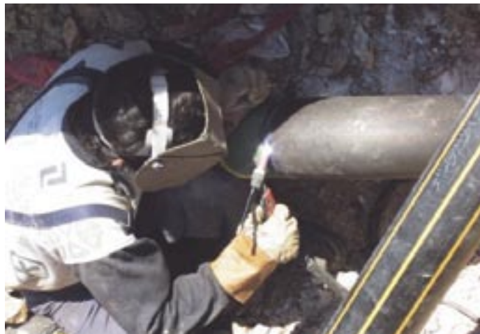
Radovi na plinifikaciji u tijeku
