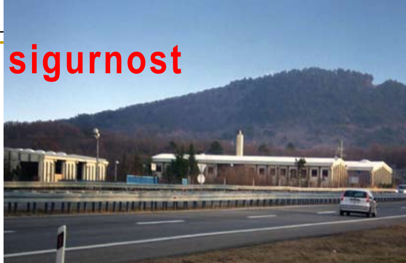
Zgrada Centra za kontrolu prometa
