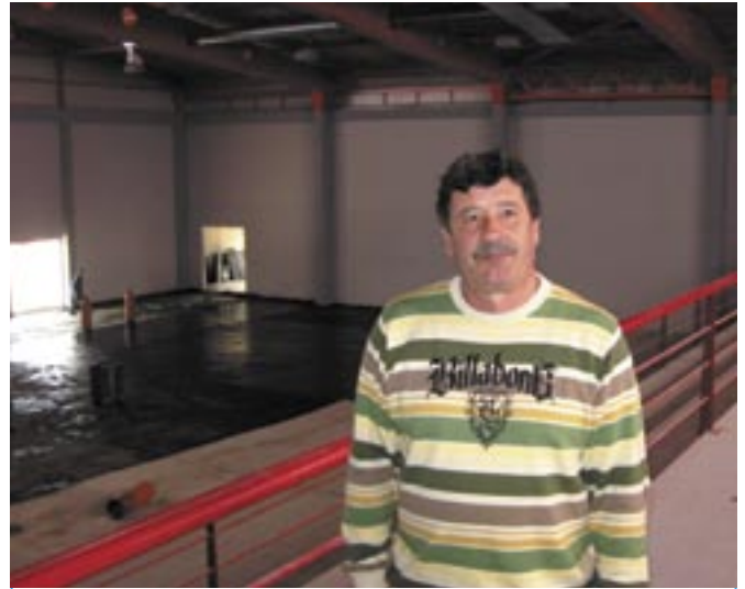
JOSIP ČARGONJA: U tijeku je uređenje podloge parketa, farbanje zidova i montaža 755 sjedalica u gledalištu
