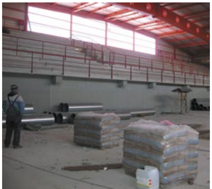
Unutarnji radovi u punom jeku
