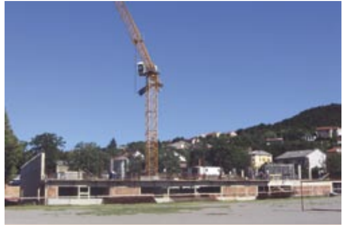
Dovršena je izgradnja prve ploče na sportskoj dvorani u Mavrincima
