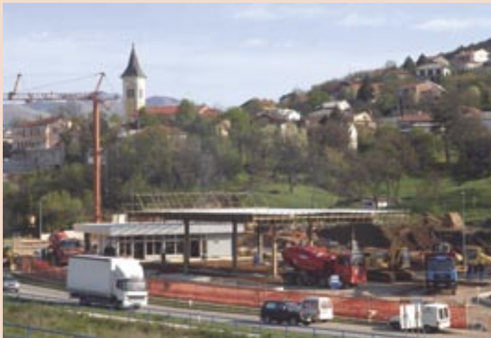
Izgradnja benzinske crpke u Cerniku
