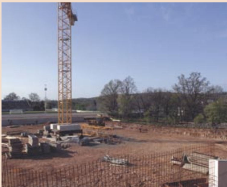
Radovi na sportskoj dvorani u Mavrincima, najvećem kapitalnom projektu Općine
